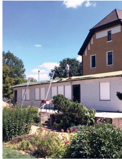
Dank der Sanierung ist das Vereinsheim nun asbestfrei. Foto: Verein
