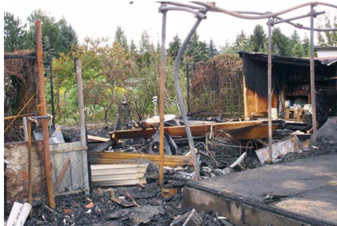
Bei solchen Schäden ist es gut, wenn die Laube richtig versichert ist. Foto: SLK
